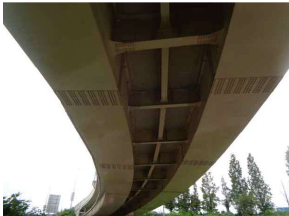
거더외부, 바닥판하면 전경
